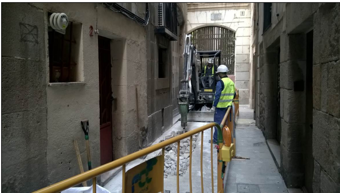
Fotografia 8. Desmuntatge de la pavimentació i de la capa de formigó al carrer de la Cirera
