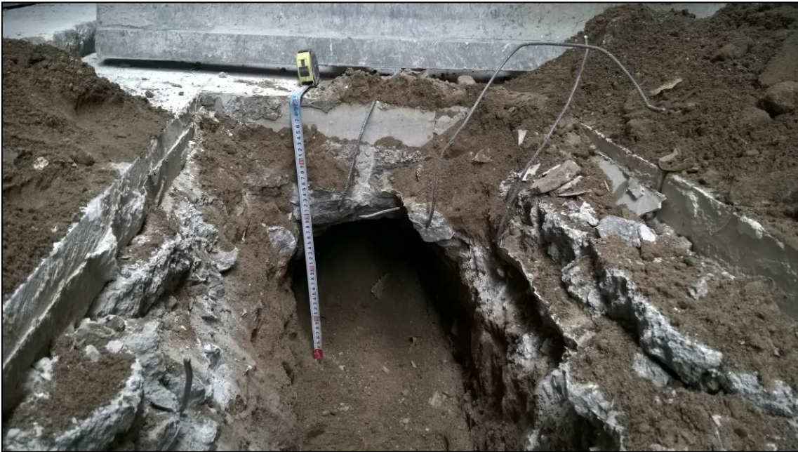
Fotografia 13. Rebaix de la rasa al carrer de la Cirera a 0,50 m
