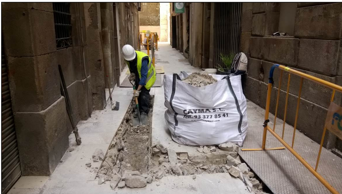
Fotografia 11. Excavació manual del tram final de la rasa al carrer de la Cirera
