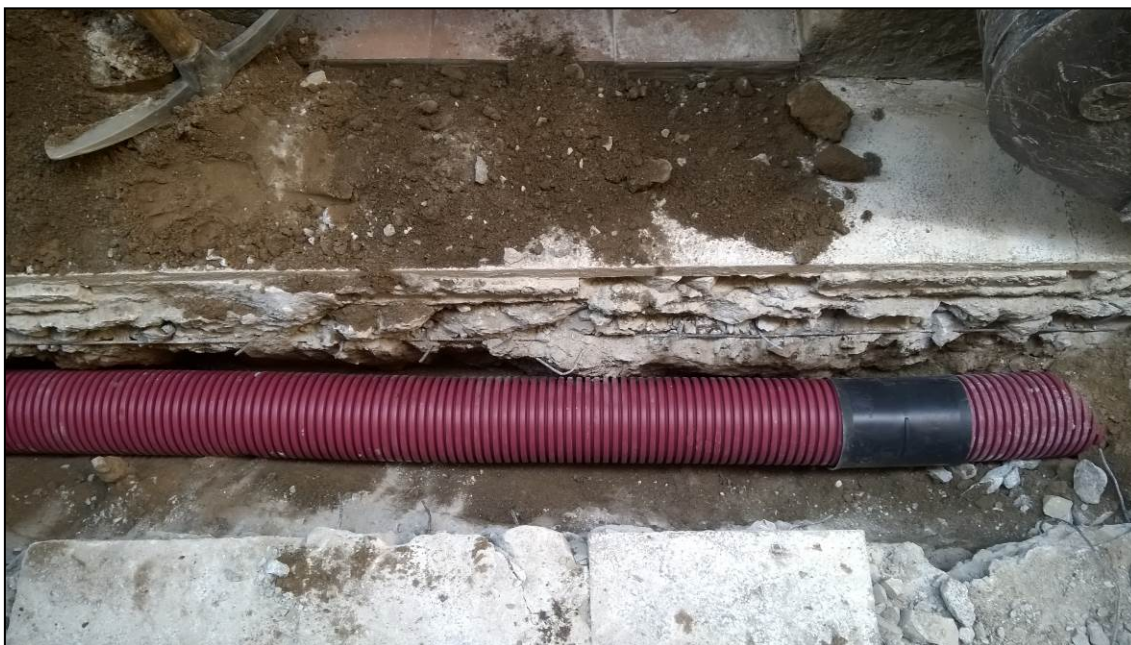
Fotografia 10. Col·locació del tub corrugat de PVC
