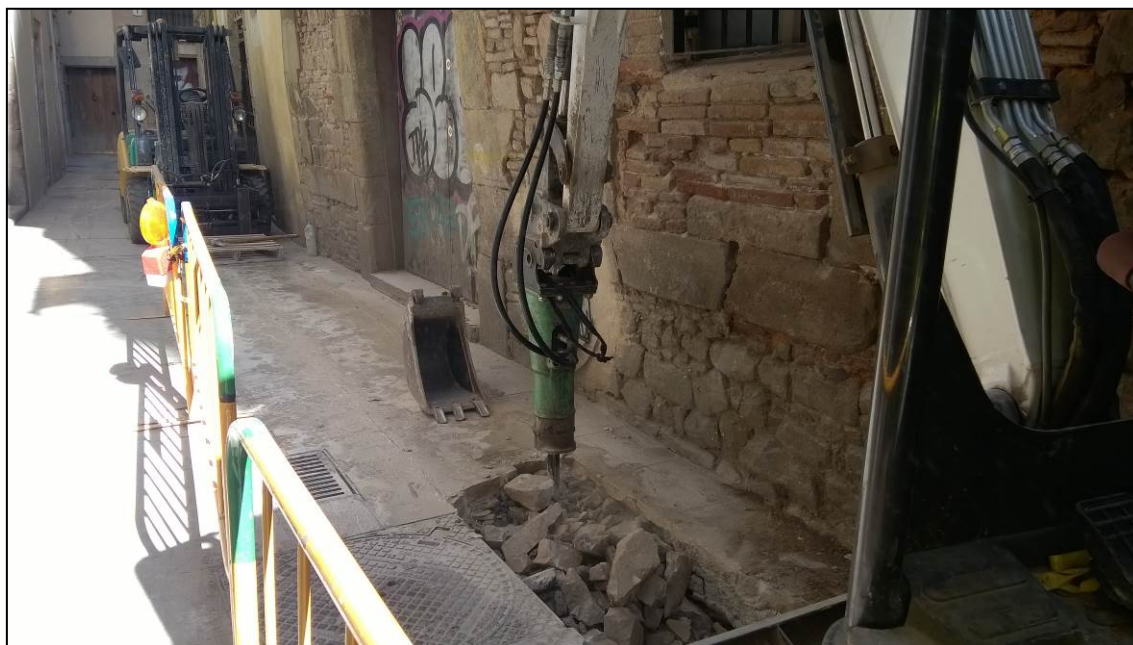
Fotografia 2. Desmuntatge del paviment i la capa de formigó mitjançant martell percutor
