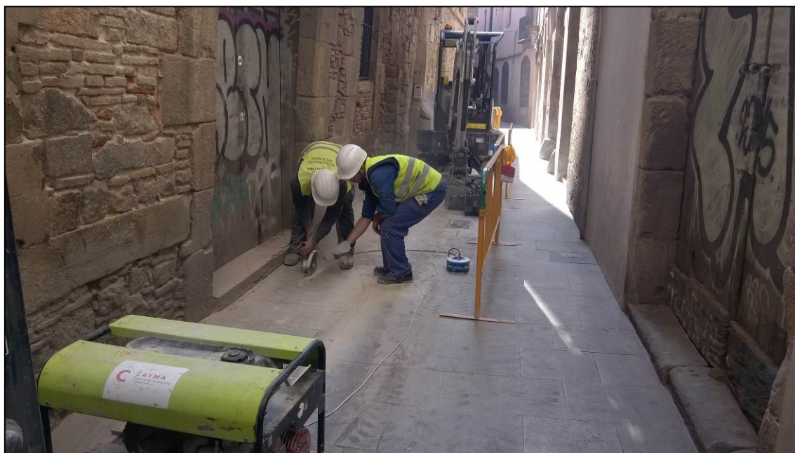
Fotografia 1. Desmuntatge amb radial de la pavimentació del carrer de la Seca
