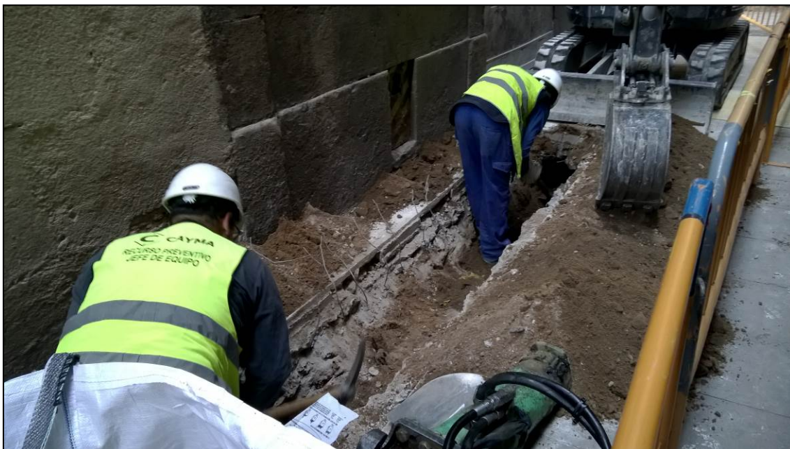
Fotografia 9. Excavació manual de la rasa al carrer de la Cirera
