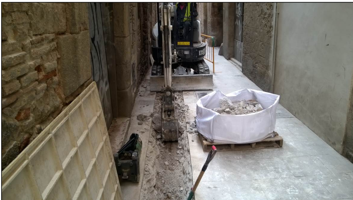
Fotografia 3. Retirada del formigó i inici d'excavació de la rasa
