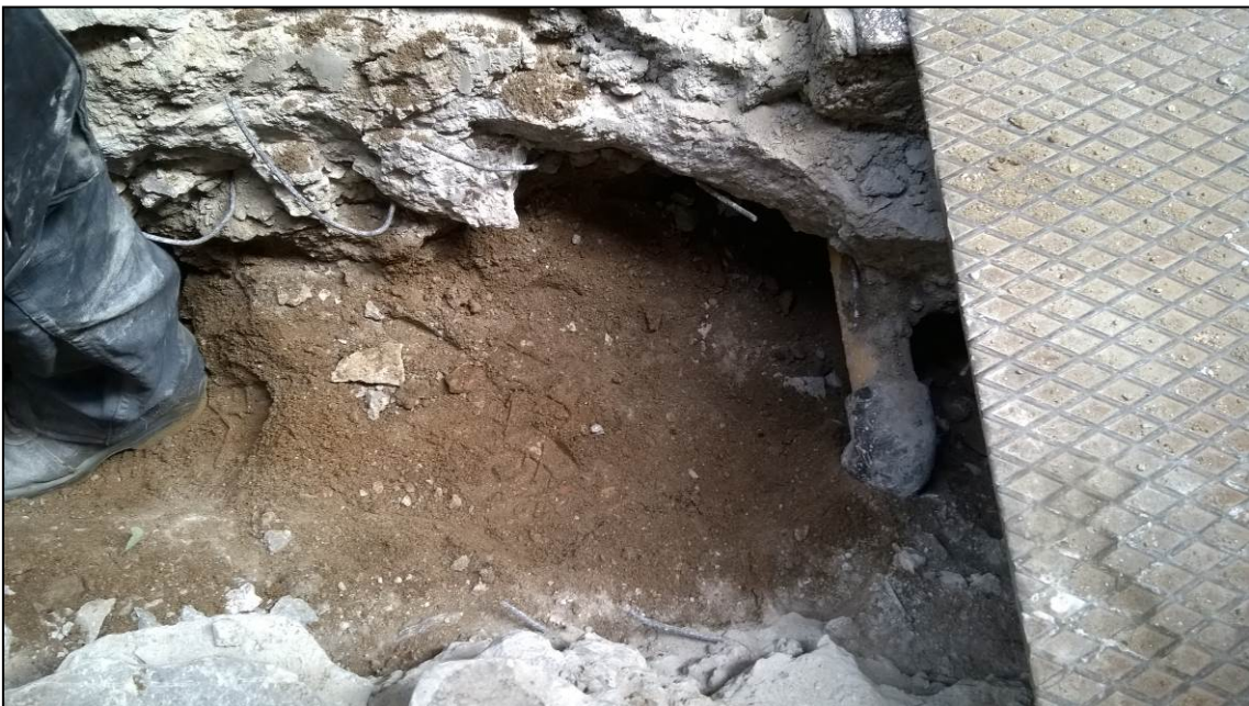
Fotografia 14. Servei de gas a la rasa del carrer de la Cicera
