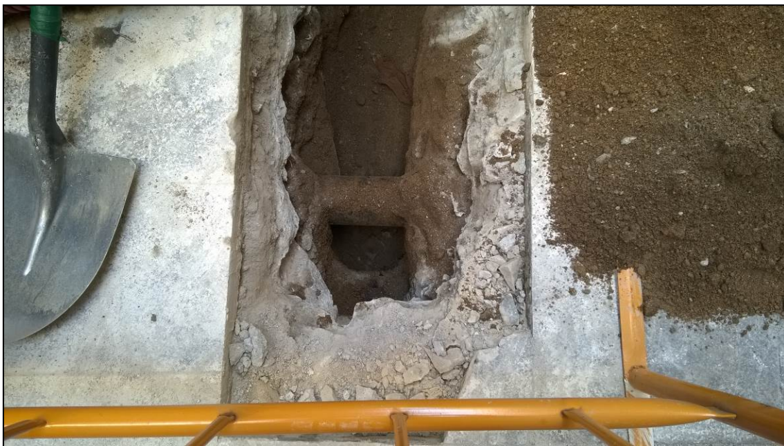
Fotografia 7. Serveis anteriors localitzats a la rasa del carrer de la Seca
