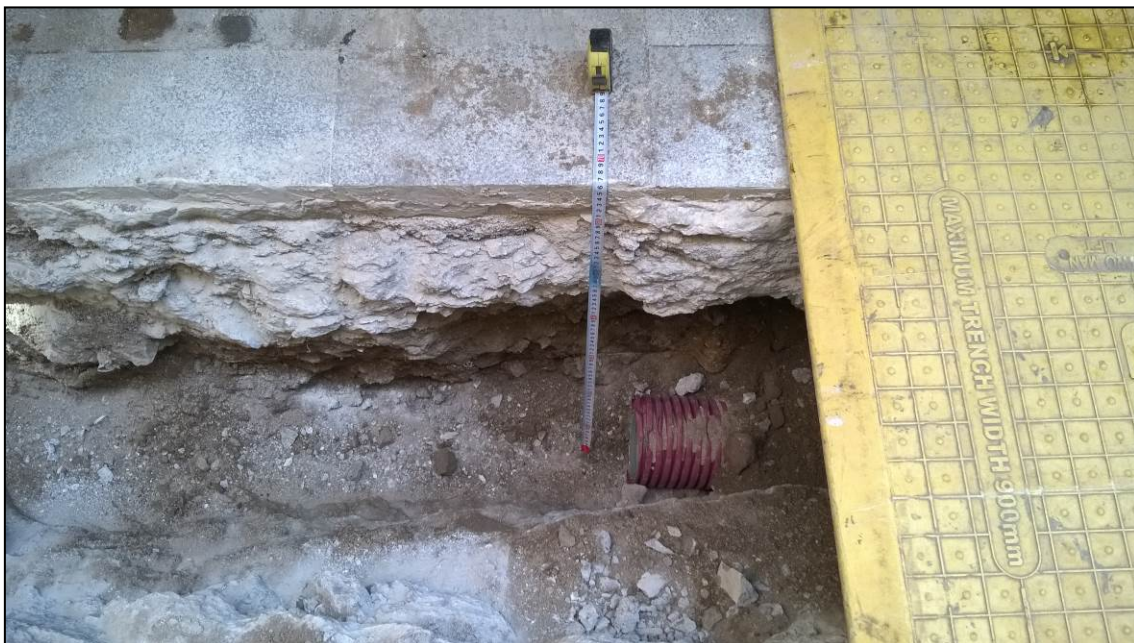
Fotografia 5. Rebaix de la rasa a 0,65 m. Carrer de la Seca
